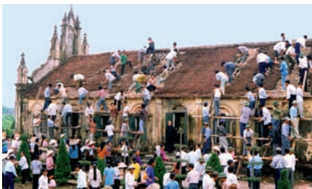
Dużo serca, wiele rąk, Państwa cegły – krycie dachu kościoła w Wietnamie.
