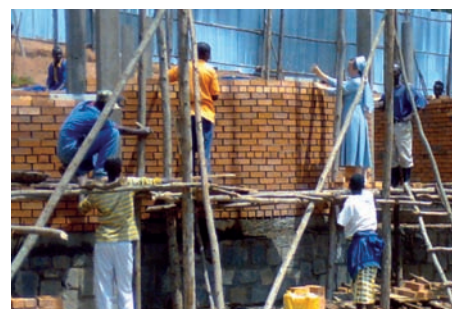
Budowa pielgrzymkowego Sanktuarium pojednania w Kibeho (Ruanda).
